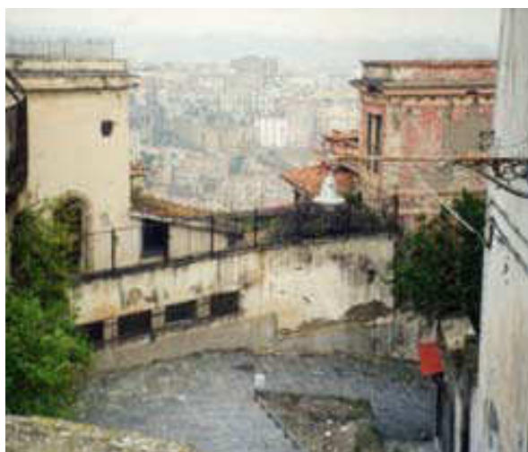
Figg. 2.8 – 2.9: Pedamentina di San Martino, muro di sostegno dissestato a seguito del nubifragio del 20 giugno 2009 e dopo l'intervento di ricostruzione.
