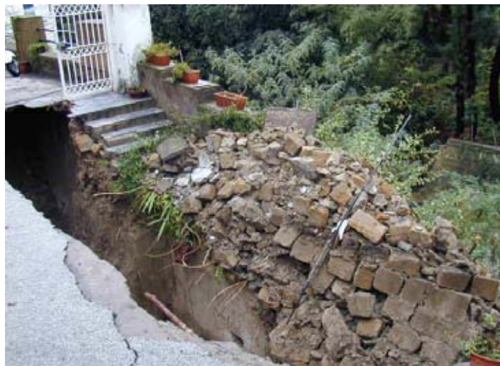
Figg. 1.6 – 1.11: Dissesto a muri di contenimento e dilavamento di fanghi e detriti in via Posillipo durante evento meteo del 6 - 7 novembre 2003 e voragine in Via Manzoni
