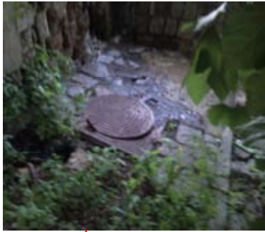
Figg. 2.10- 2.13: Voragine in Largo San Martino per perdita dell'acquedotto e detriti nelle tubazioni fognarie poste a valle dello sprofondamento, in via Pedamentina altezza civico 37, che hanno provocato fuoriuscita d'acqua dai pozzetti fognari in pressione in data 6 maggio 2011
