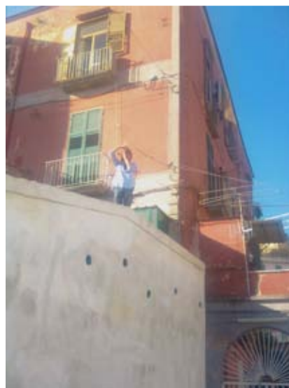
Figg. 2.8 – 2.9: Pedamentina di San Martino, muro di sostegno dissestato a seguito del nubifragio del 20 giugno 2009 e dopo l'intervento di ricostruzione.
