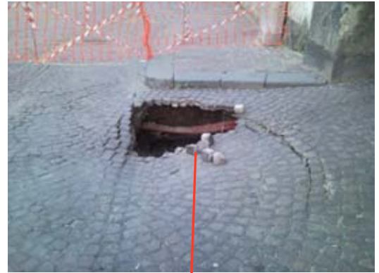
Figg. 2.10- 2.13: Voragine in Largo San Martino per perdita dell'acquedotto e detriti nelle tubazioni fognarie poste a valle dello sprofondamento, in via Pedamentina altezza civico 37, che hanno provocato fuoriuscita d'acqua dai pozzetti fognari in pressione in data 6 maggio 2011
