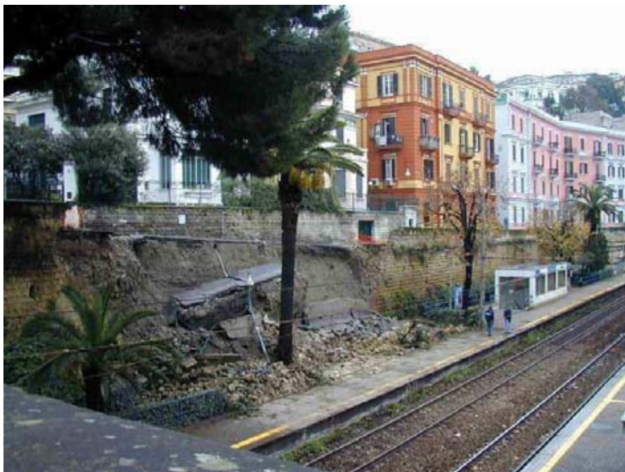
Fig. 1.23: Crollo muro di contenimento in Viale Maria Cristina di Savoia (binari Cumana),
