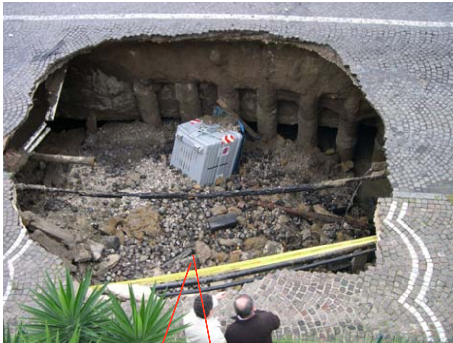
Figg. 1.4 – 1.5: Dissesto rete fognaria Via Posillipo altezza deposito ANM - 7.11.2003
