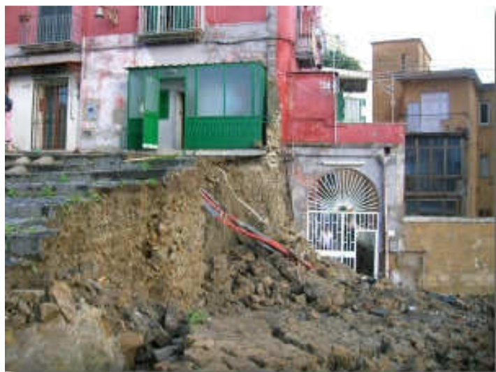
Figg. 2.8 – 2.9: Pedamentina di San Martino, muro di sostegno dissestato a seguito del nubifragio del 20 giugno 2009 e dopo l'intervento di ricostruzione.
