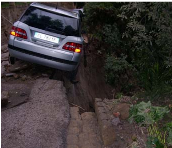
Figg. 1.6 – 1.11: Dissesto a muri di contenimento e dilavamento di fanghi e detriti in via Posillipo durante evento meteo del 6 - 7 novembre 2003 e voragine in Via Manzoni
