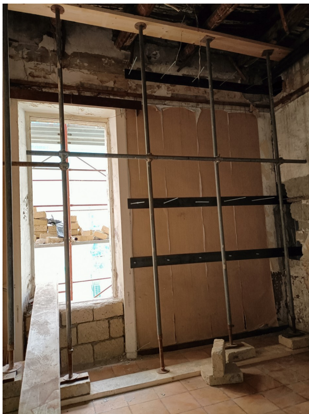
Foto 10 – parziale puntellamento e messa in opera di contro-piastre in acciaio
