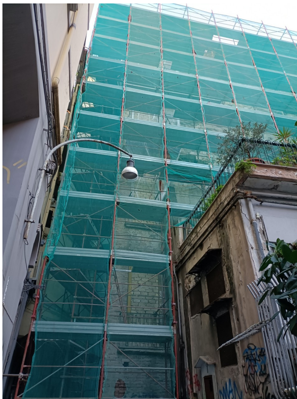
Foto 3 – ponteggio installato
