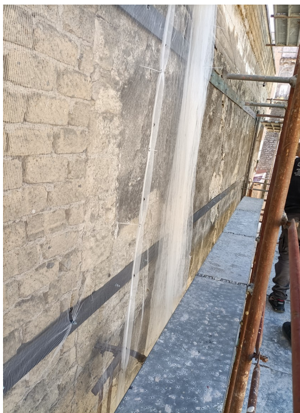
Foto 6 – piastre in acciaio messe in opera
