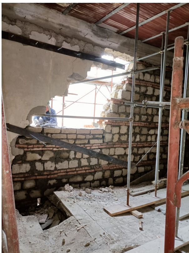
Foto 14 - ricostruzione della muratura
