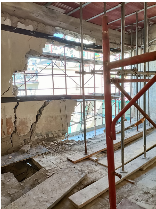
Foto 12 – muratura disestata parzialmente demolita e solaio copertura puntellato
