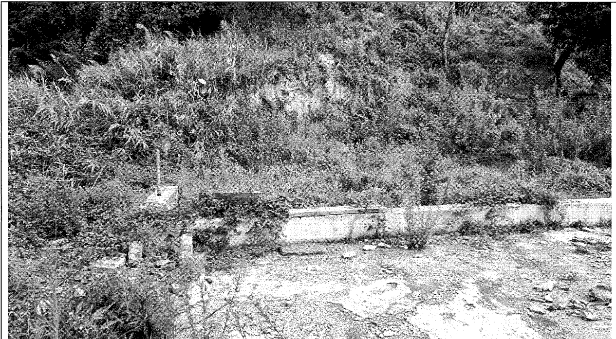
Dividente corrispondente con il muro di delimitazione del canale su confine nord
