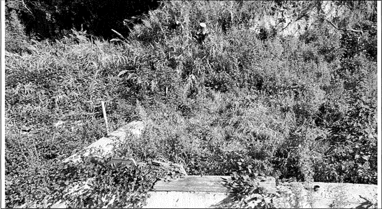
Dividente corrispondente con il muro di delimitazione del canale su confine nord
