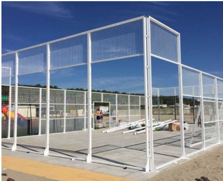
Foto dal web. Elementi in fase di montaggio
