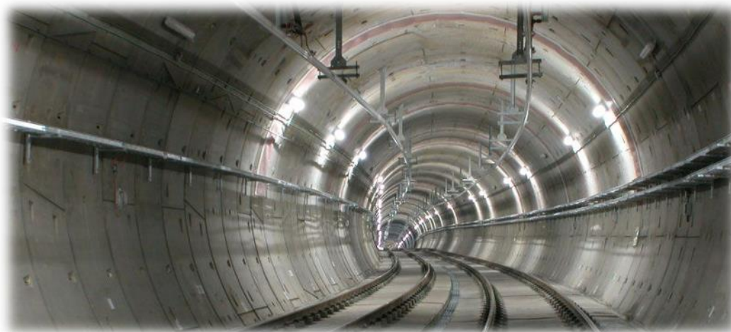
Figura 19 - Esempio di catenaria rigida in galleria
