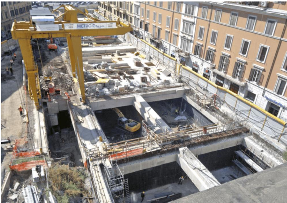
Figura 13 - tipologico stazione top-down
