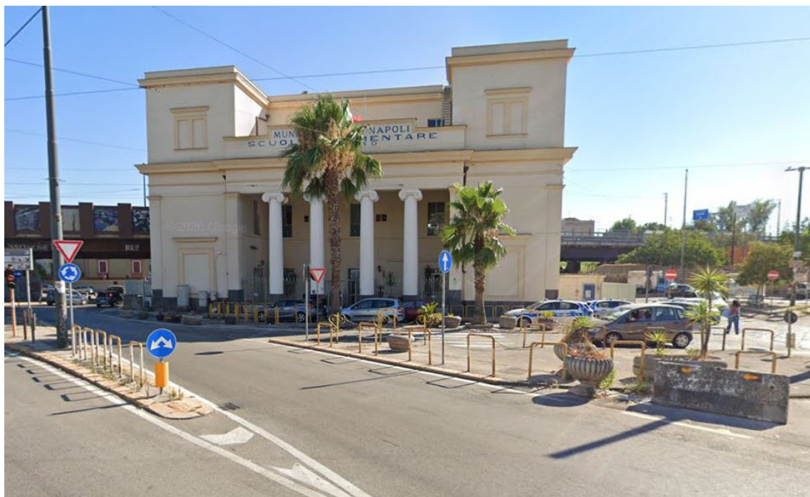
L'edificio ottocentesco dell'ex Dogana. Documentazione fotografica dello stato dei luoghi
