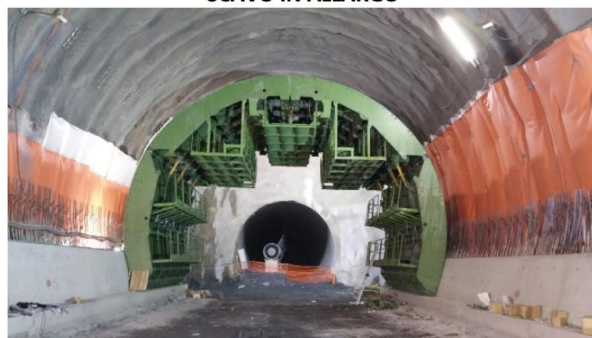
GETTO RIVESTIMENTO DI CALOTTA
