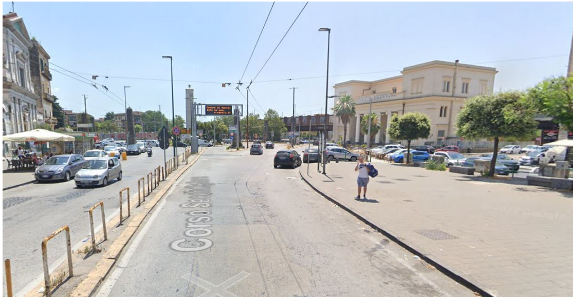
Piazza Di Vittorio. Documentazione fotografica dello stato dei luoghi
