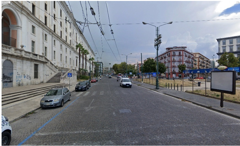
Piazza Carlo III. Documentazione fotografica dello stato dei luoghi
