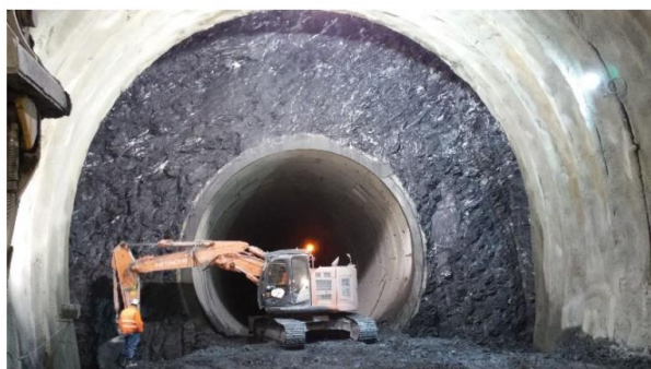
DEMOLIZIONE CONCI TBM
