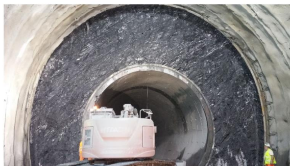
SCAVO IN ALLARGO
