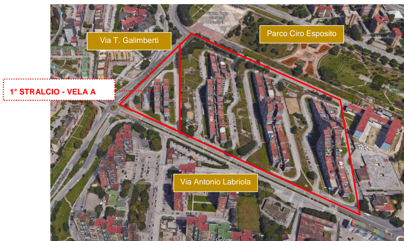
Vista generale area di intervento
