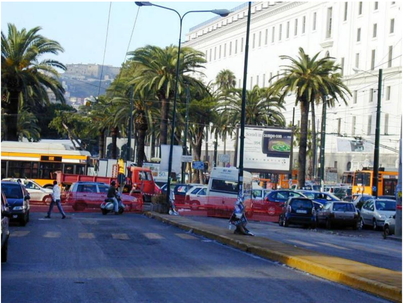
Ponte in Via Don Bosco – Dissesti al manto stradale. (28.09.2007)
