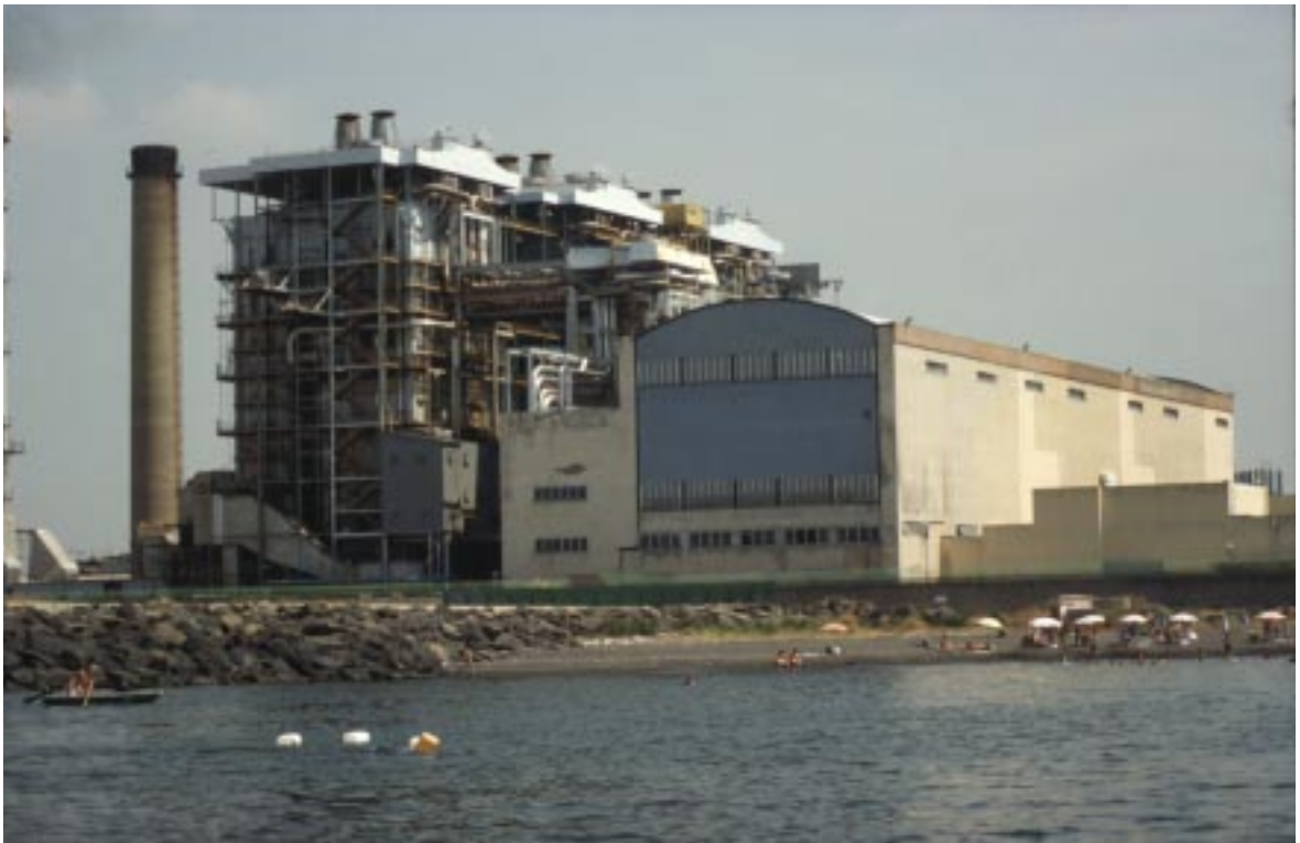
Fig.11. La centrale termoelettrica di Vigliena e il lembo di spiaggia sottostante (foto G. Dispoto).
