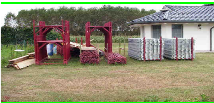
Fig.9 Deposito ponteggio a telai prefabbricati
