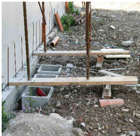
Figura 12 – base ponteggio
