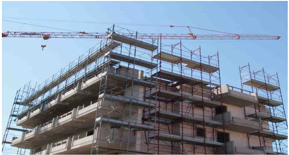
Fig. 7 Ponteggio avente diversa profondità in funzione della pianta dell'edificio
