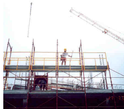
posa correnti parapetto
