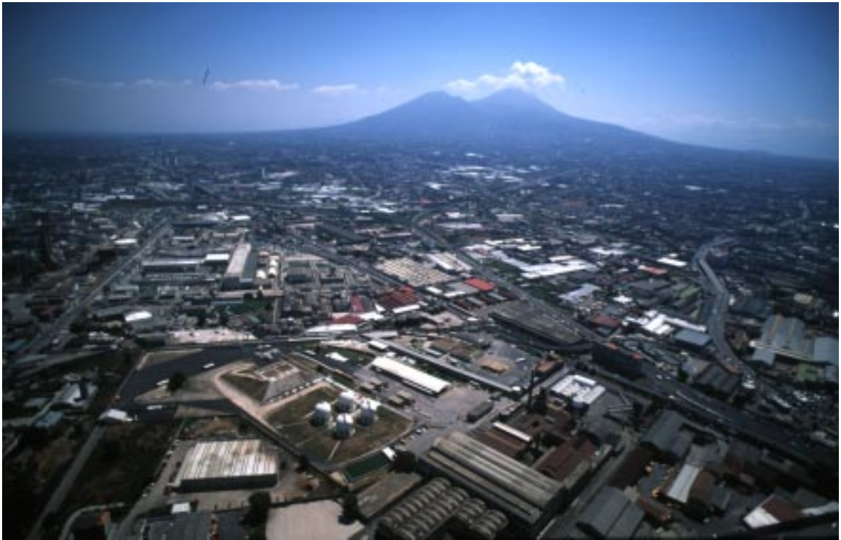
Fig.5. Veduta della zona industriale.
