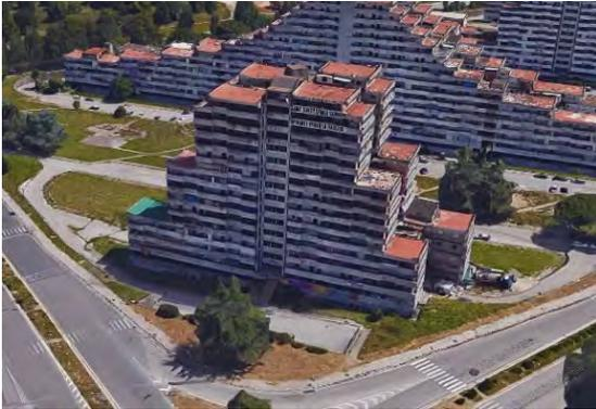
quattro presenti nel lotto, è localizzata sul fronte ovest dell'area e si sviluppa in verticale con un impianto a "Torre" su 16 livelli fuori terra, anche se di superficie inferiore man mano che si sale in quota. Presenta in pianta una forma ad H, con parte centrale di collegamento tra i quattro blocchi longitudinali disposti su due allineamenti paralleli.
