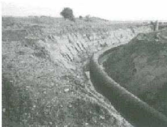
La pieghevolezza è da intendersi anche come flessibilità in senso lato, per le possibilità di applicare una molteplicità di soluzioni "non standard" grazie alla saldabilità del polietilene, che permette di costruire qualsiasi tipo di pezzo speciale (pozzetto - curva - derivazione ecc.), nonché di effettuare giunzioni per saldatura di testa particolarmente sicure in caso di presenza di falda per una perfetta impermeabilità, quindi per la realizzazione di reti perfettamente monolitiche (stagne).
