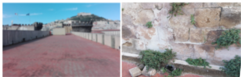
INTERVENTO N°03 INTERVENTO SULLE MERALATURE
