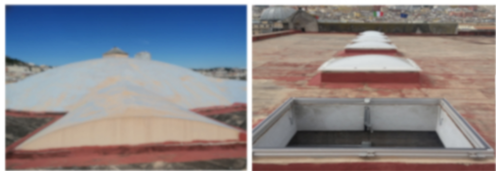
INTERVENTO N°02 INTERVENTO SULLE COPERTURE PIASTRELLATE
