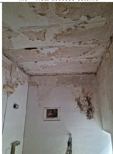
n.10 – vista infiltrazione
