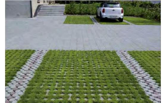
ESEMPIO DI STALLI REALIZZATI CON PAVIMENTAZIONE IN MASSELLO DRENANTE
