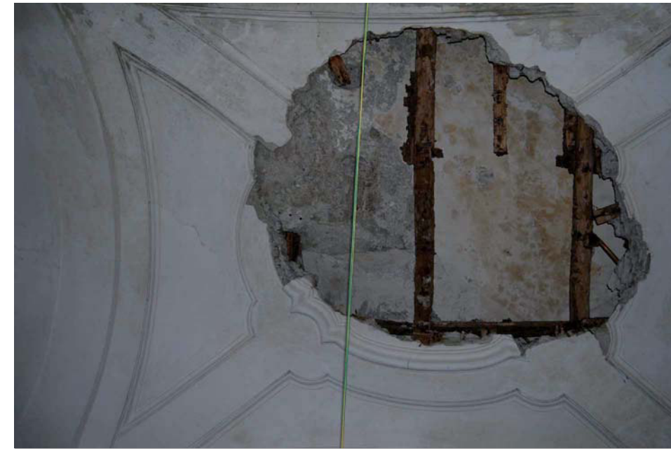
•14. Crollo della volta dell'ambiente attiguo alla Chiesa
