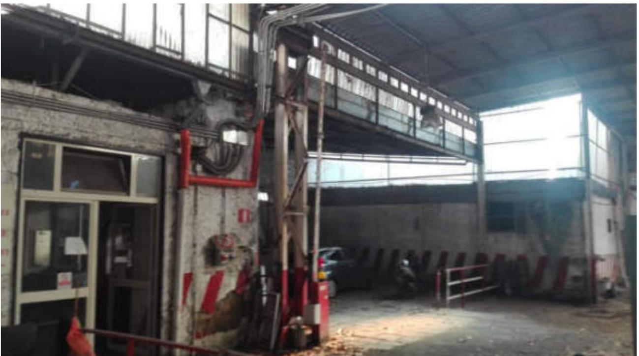
Foto n. 16. Vista della zona di ingresso al capannone di via Nicolini n. 47. Si distingue in primo piano a sinistra il vecchio corpo di fabbrica in muratura di tufo ad unico livello posto sul fronte strada di via Nicolini ed a destra l'area di ingresso al capannone prima scoperta e poi coperta con lamiera.
