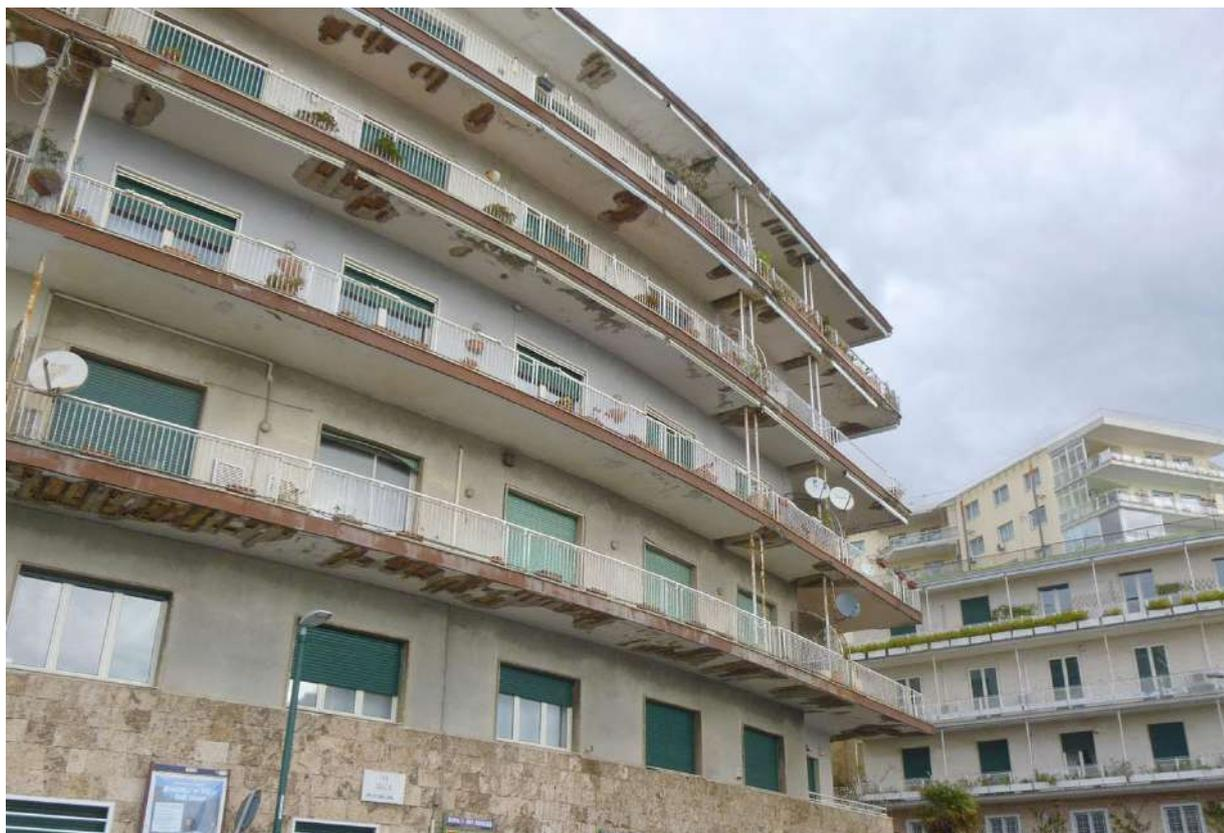
**Foto 3-** Edificio di recente formazione con distacchi di intonaco all'intradosso delle solette dei balconi
