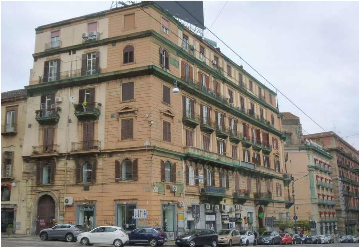
**Foto 1-** Edificio novecentesco con distacchi di intonaco da balconi e cornicioni
