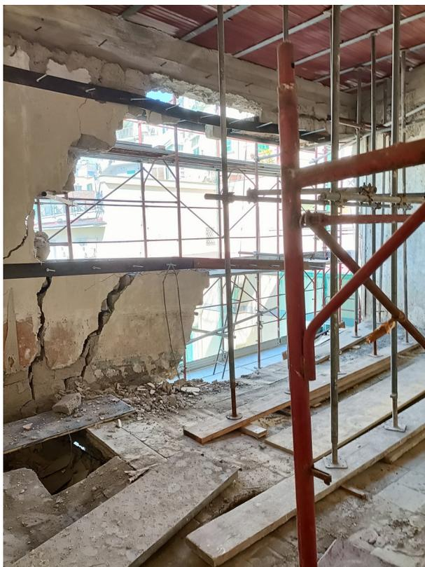
Foto 12 – muratura dissestata parzialmente demolita e solaio copertura puntellato
