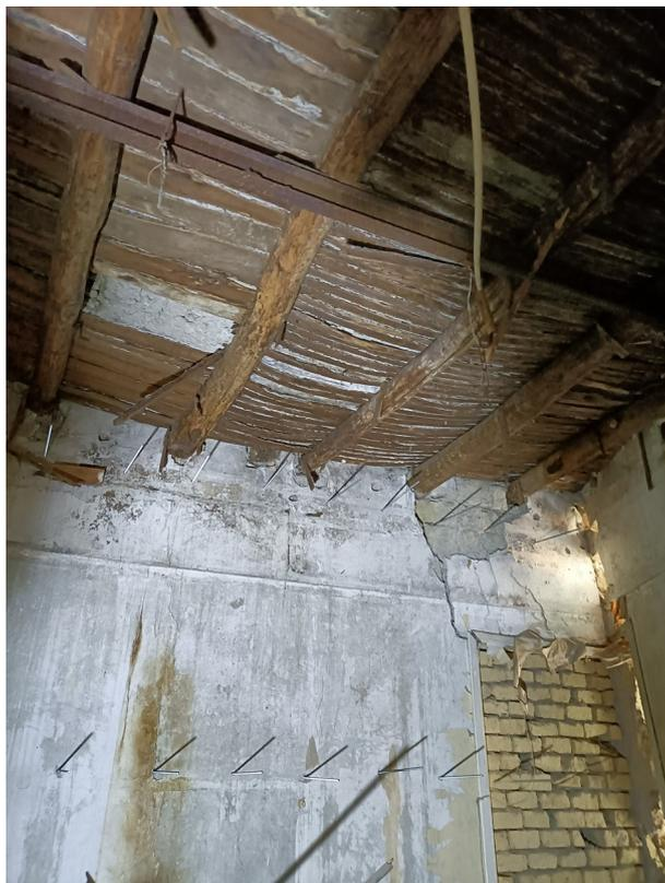
Foto 8 – solai lignei degradati
