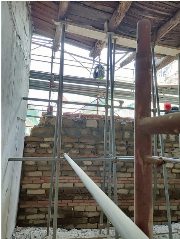
Foto 13 – ricostruzione della muratura
