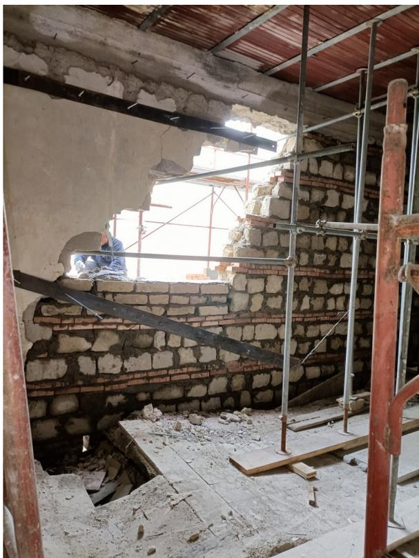
Foto 14 – ricostruzione della muratura
