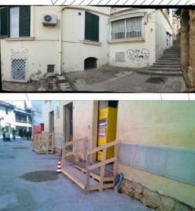
DOPO LA DEMOLIZIONE DEI GRADINI DI ACCESSO ALLE ABITAZIONI RIPRISTINARE GLI STESSI IN MANIERA PROVVISORIA CON TAVOLATI DI LEGNO E SABBIA TIPOLOGICO PER GARANTIRE L'ACCESSO AI FABBRICATI IN CONDIZIONI DI DISLIVELLO SIGNIFICATIVO
