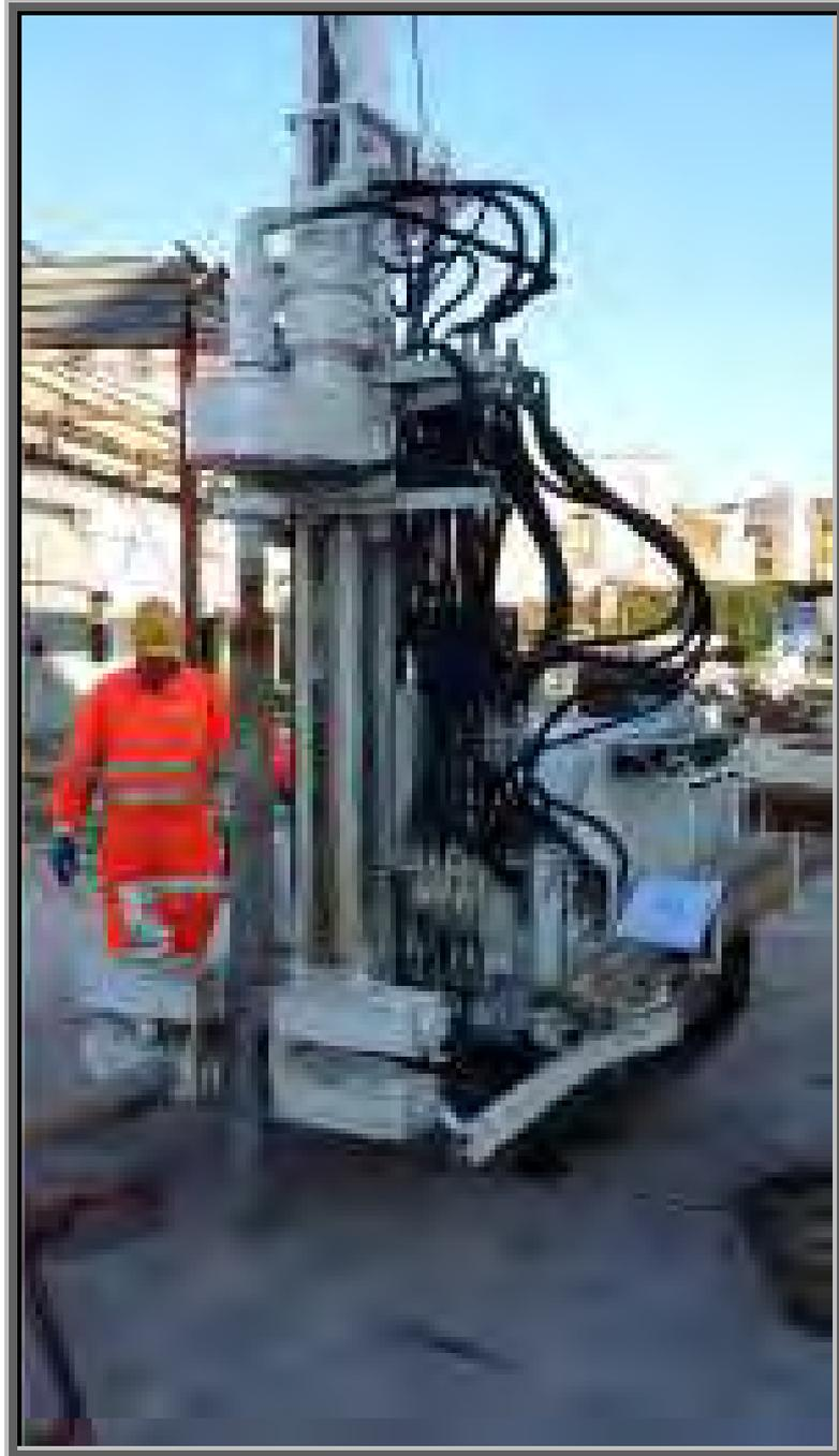
*Piazzamento perforatrice per esecuzione Sondaggio "C4"*
