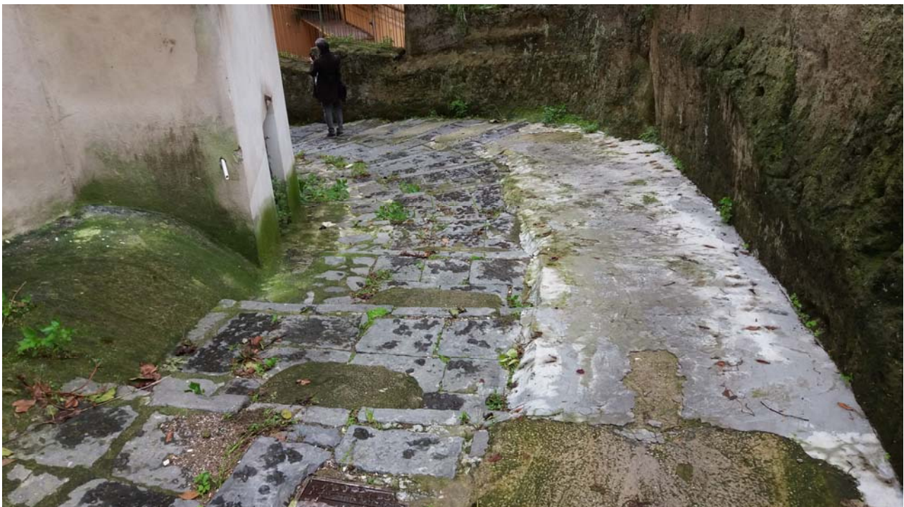
Figura 6 - Salita Caciottoli – tratto terminale con evidenti rimaneggiamenti del piano strada senza caditoie
