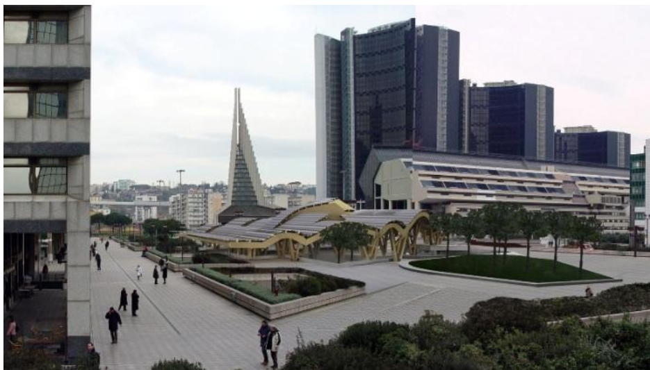
Figura 1-4 – Stazione Centro Direzionale
