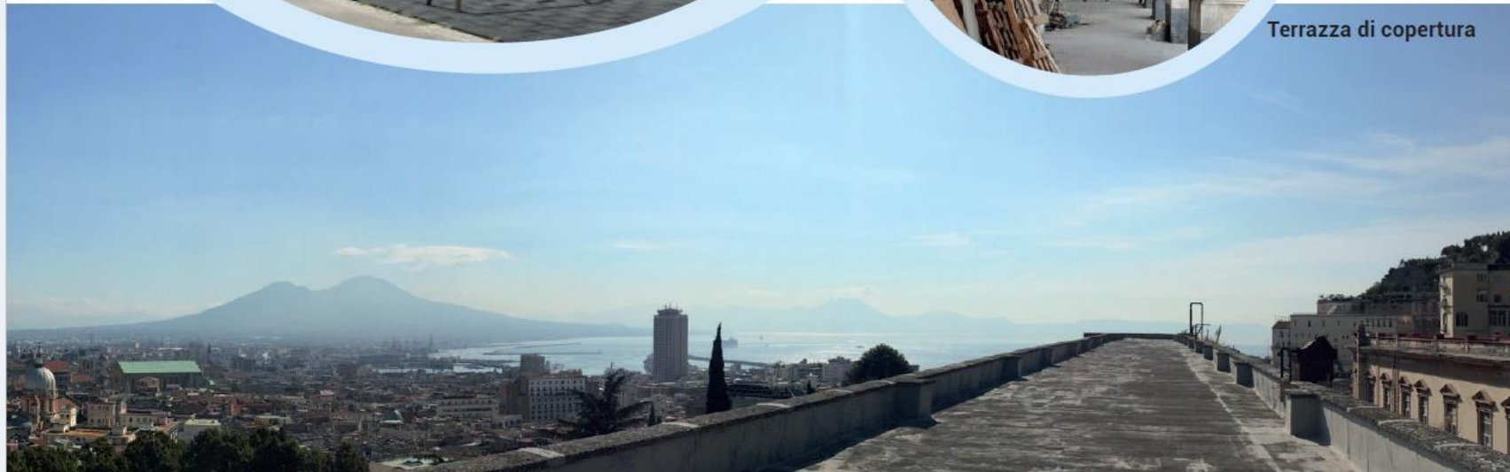
L'edificio C, il portico, la terrazza di copertura
