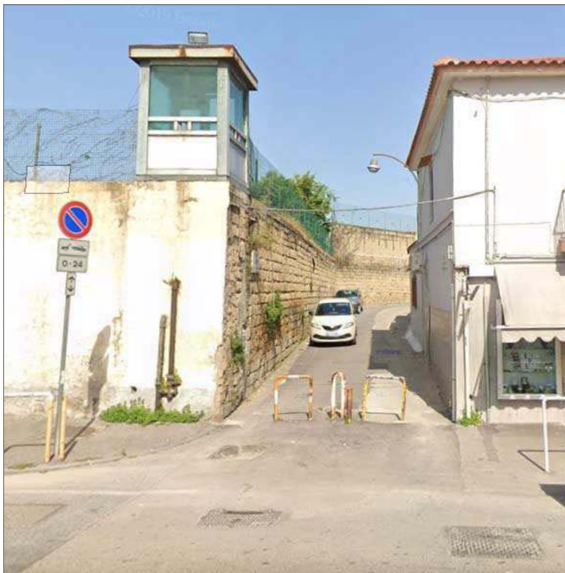
Figura 2.4 - Accesso di Cupa Cardone su Via Miano, attualmente chiuso al traffico
