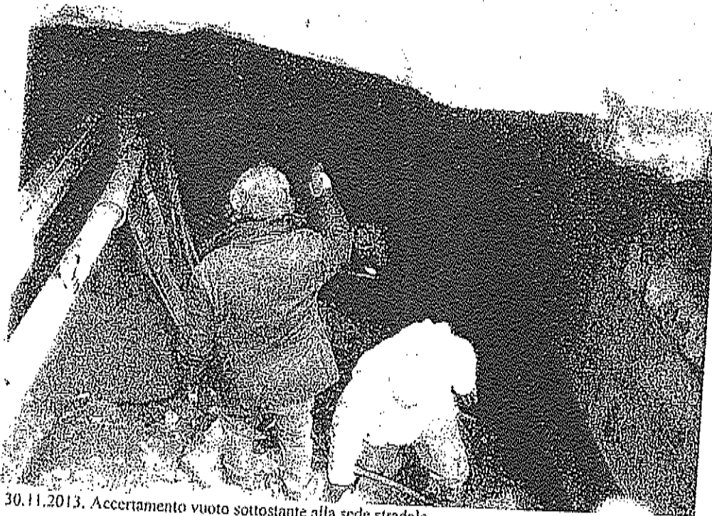
Foto 5 - 30.11.2013. Creazione accesso alla cavità. Stato dei luoghi sottostante alla colonnina telefonica.
