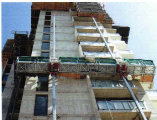
Figura 15 Ponteggio mobile elettrico-autosollevante.
